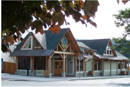
Lake George Visitor Center Exterior
